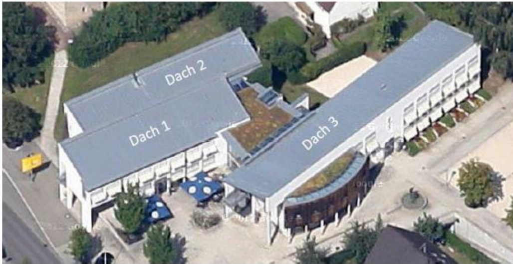
Dachübersicht – BV Rathaus Wannweil
